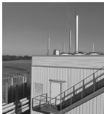
À la SCEA Cheminant, à Carquefou (44), trois unités de cogénération sont utilisées pour chauffer une dizaine d'hectares de serres. Mais elles fonctionnent rarement toutes les trois en même temps.
